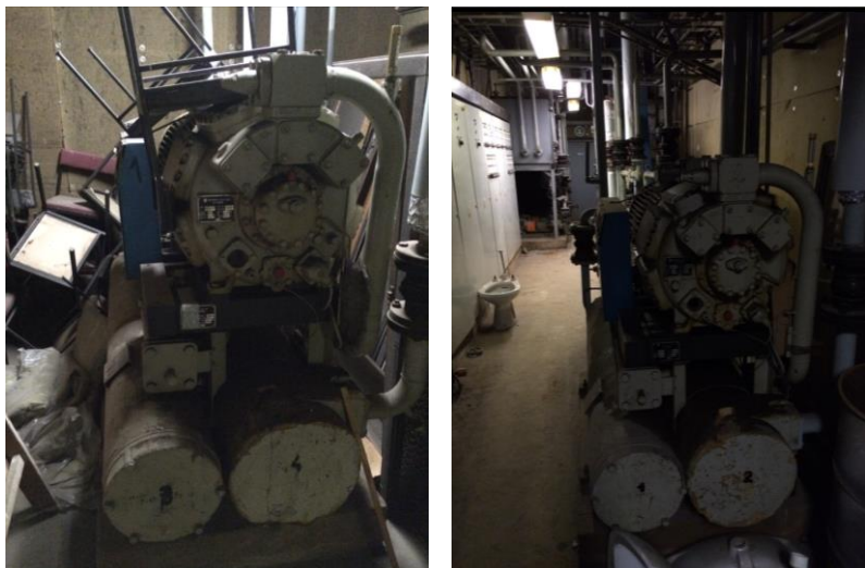
Obrázek 6 - Pohled na vyřazené a dlouhodobě nefunkční kompresorové zdroje chladu ČKD
