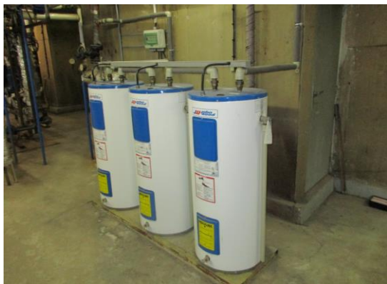
Obrázek 4 - Akumulační el. zásobníky přípravy TV
