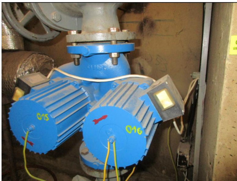
Obrázek 3 - Oběhová čerpadla Sigma Lutín
